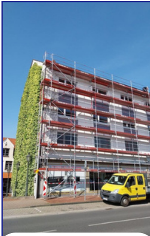
Fassadengerüst
